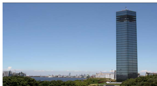
千葉ポートタワー (写真提供:(株)三越環境ビル管理様)
